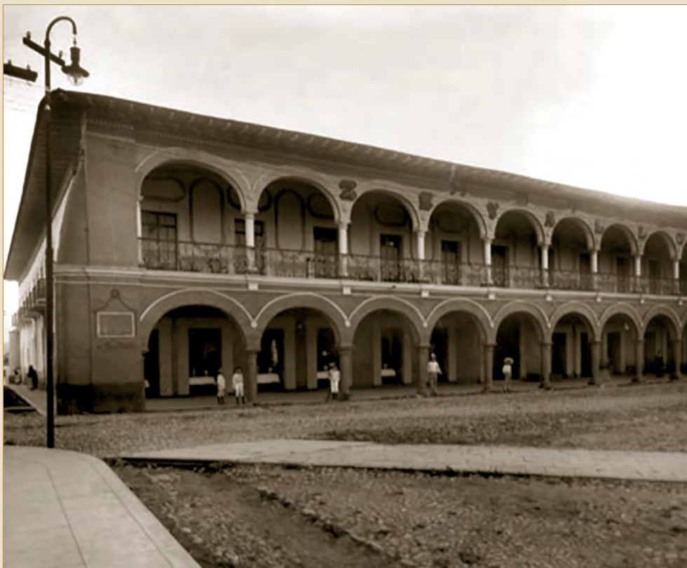
Casa donde se firmaron los Tratados de Córdoba, fachada, ca. 1900.
