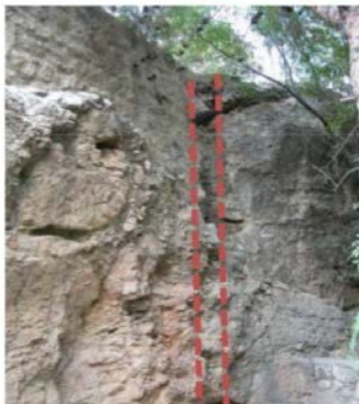
Grieta formada justo al lado de la Cruz
